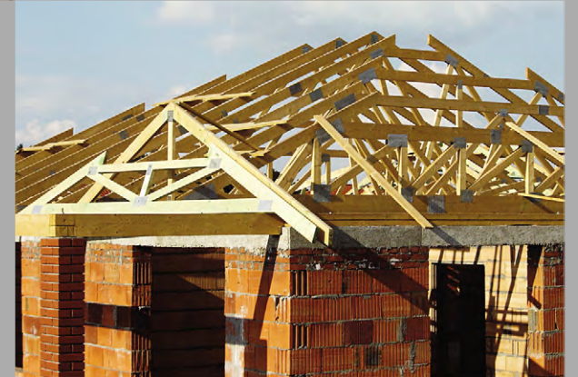
■ Dachkonstruktion eines Einfamilienhauses
